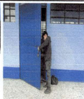
Foto No. 6 Sustitución de puerta de metal para gabinete, sustitución de puerta de metal, sustitución de chapa sobrepuesta Yalle
